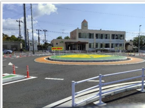
八積駅ラウンドアバウト交差点が完成しました
