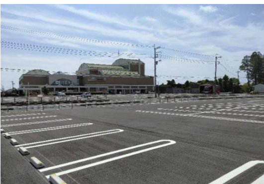
文化会館の改修工事
